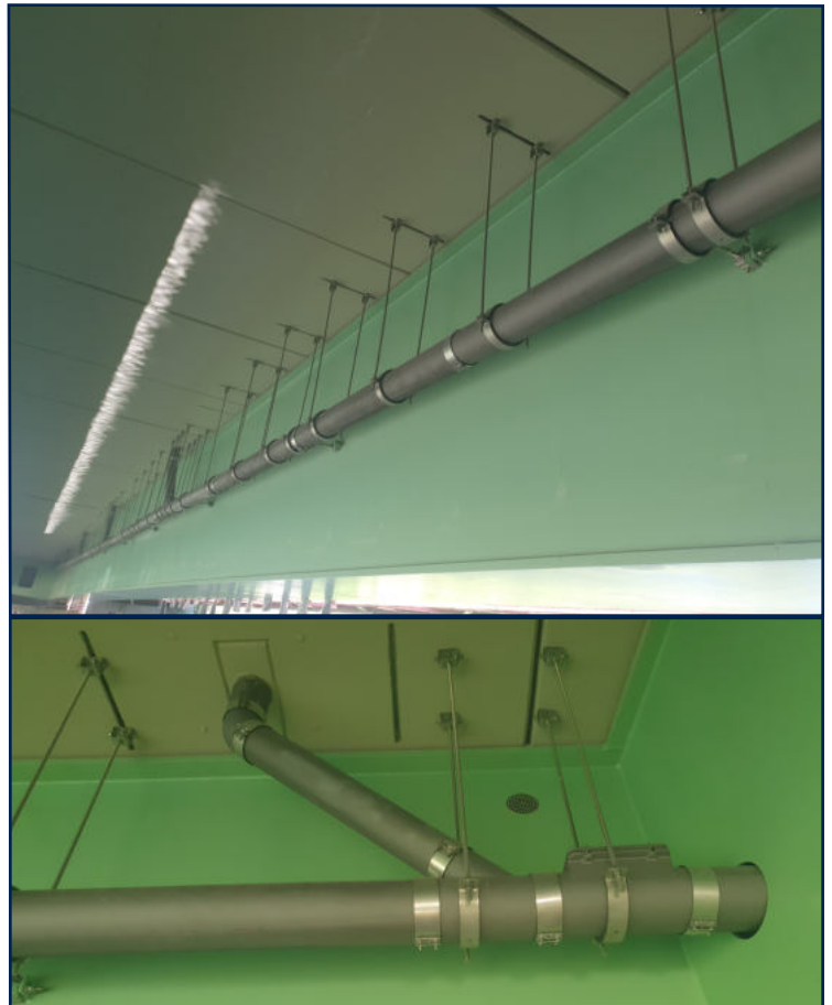
B233, Lippebrücke, Bergkamen
