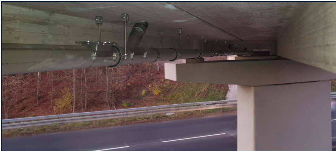
Brücke Lauf-West, Lauf an der Pegnitz
